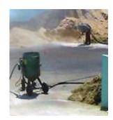
Besteht der Untergrund aus Altfliesen oder Trockenbauplatten, ist eine gesonderte Untergrundvorbehandlung (Sandstrahlen) erforderlich.
